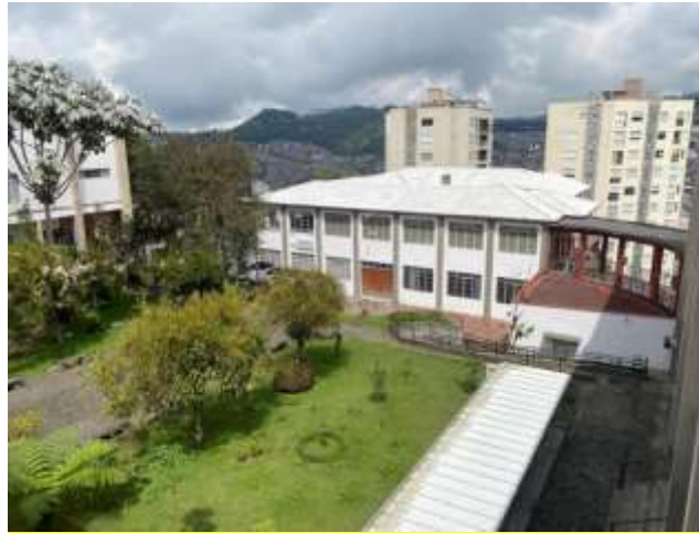
Figura 48. Adecuación de Cubierta Museo Campus Palogrande
