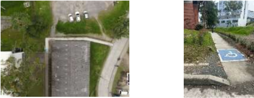
Figura 51. Adecuación Circulación Exterior Coliseo PMR
