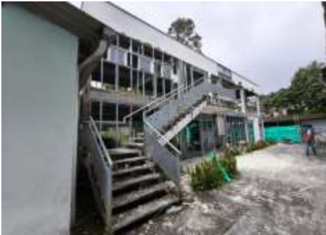
Figura 54. Adecuación Edificio Mecatrónica
