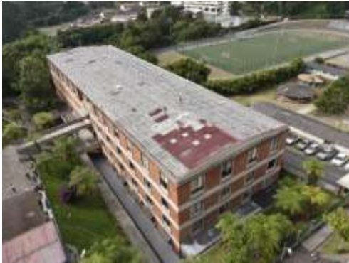
Figura 60. Instalación Sobrecubierta Edificio Administrativo
