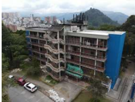
Figura 49. Adecuación Fachada Edificio Laboratorios
