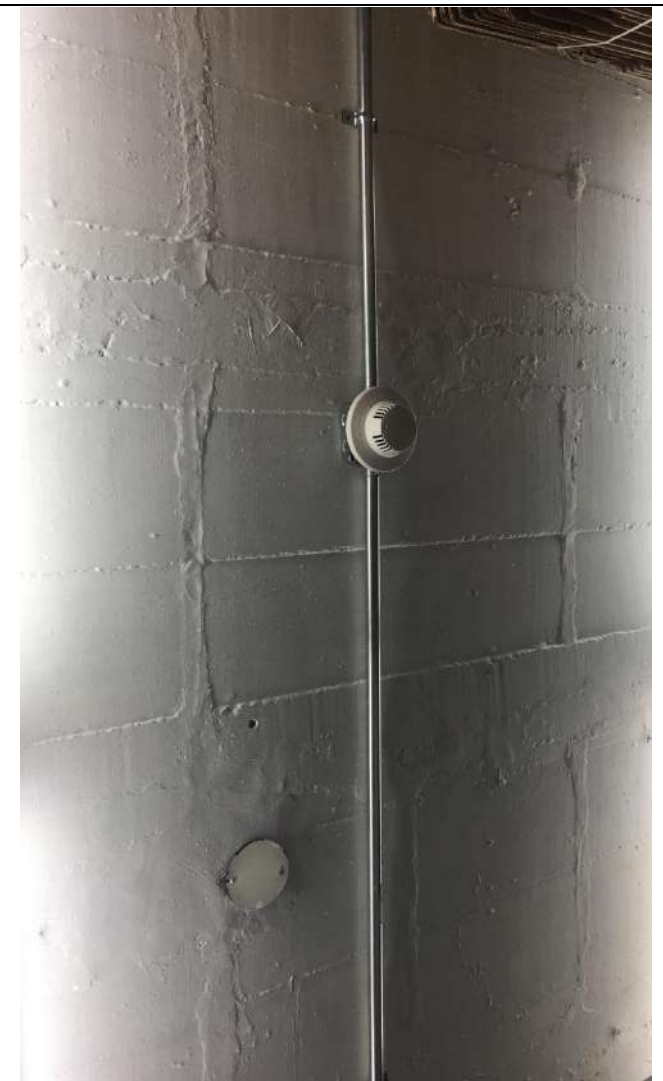
Ilustración 4. Distribución Red Sistema de Detección de incendio
