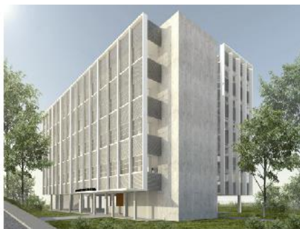
Edificio de Laboratorios
