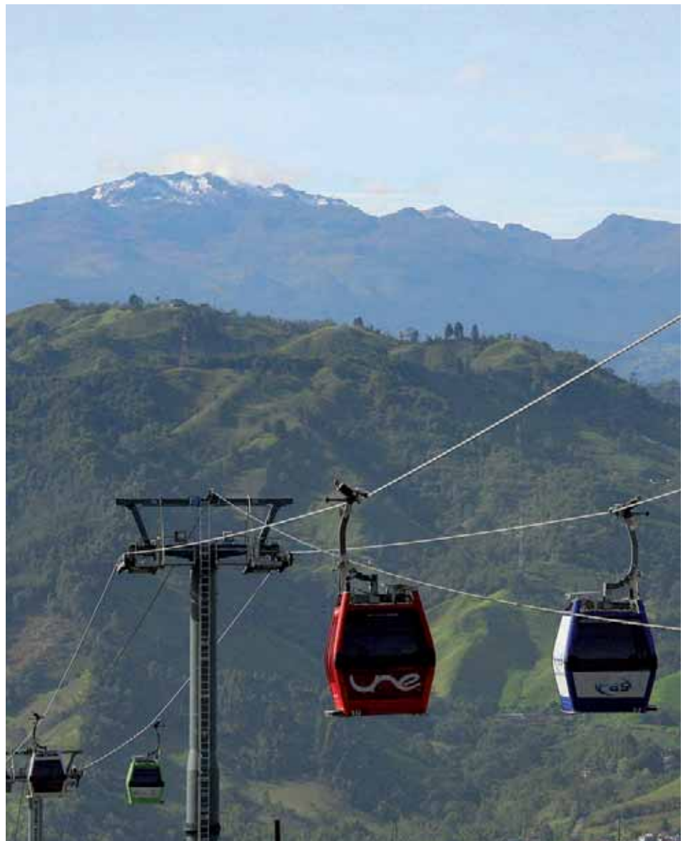
EL CABLE AÉREO SE DESTACA POR SER UNA OBRA DE INGENIERÍA DE GRAN CALIDAD EN LA CAPITAL DE CALDAS.
